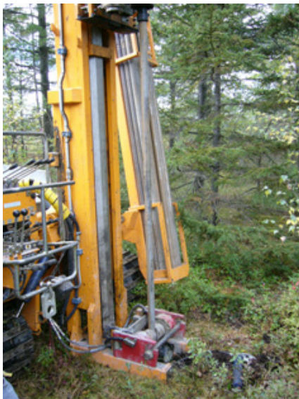
Figure 4. Forage d'un piézomètre (CNC1)
